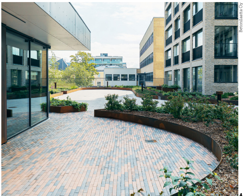
4 Kuva Sappalinan työmaalta Turusta (TKU-Rakennus Oy), jossa on käytetty vähähiilistä Beto- pihatiiltä koko 240×60×80 mm.
