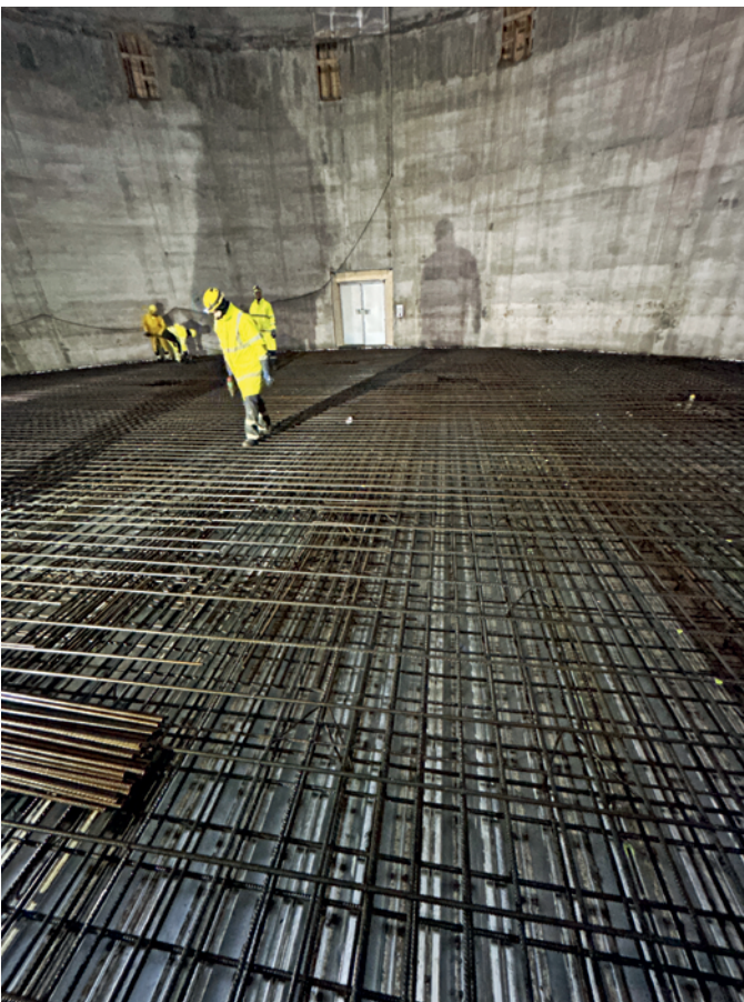
2 Tornin tuleva prosessitila ylhäältä kuvattuna. Liukuvalupinnalle tyypilliset renkaat näkyvät hyvin sisäpinnassa.
