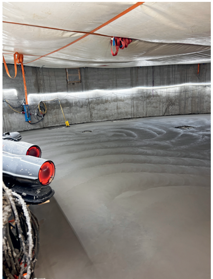
3 Betonin valu käynnissä liukuvalulautalla, sadan metrin korkeudessa.
