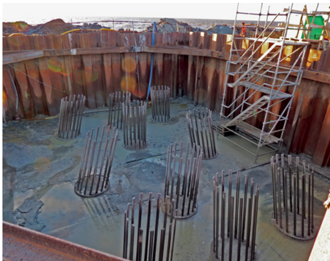
8 Riutun sillan ponttikasuuni työbetonin ja paalujen valun jälkeen.
