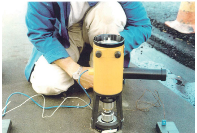
10 Pintalaatan tartuntalujuuden mittaus
