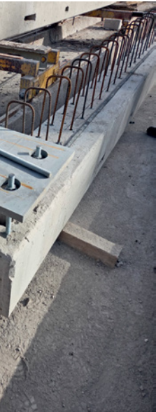
10a, b Asuinkerrostaloon asennetut betonipalkki ja pilarit kolmannessa pilotissa Hiedanrannassa, oikealla palkin kunnostusta tehtaalla.
