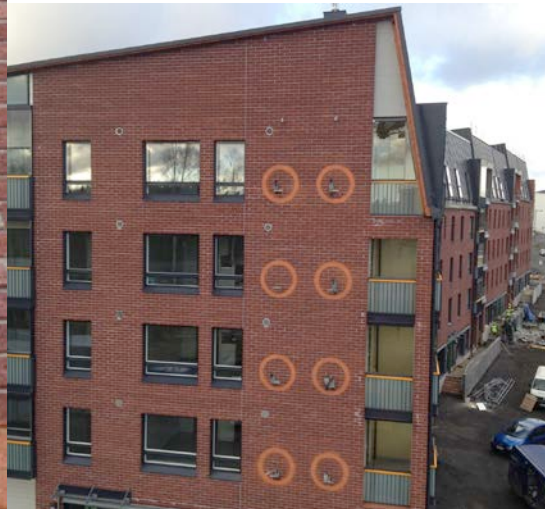
Pertti Kukkonen: Variksen peli, 2012, betoni ja teräs
