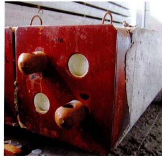
Figur 5.3 Typisk peleskjøt.
