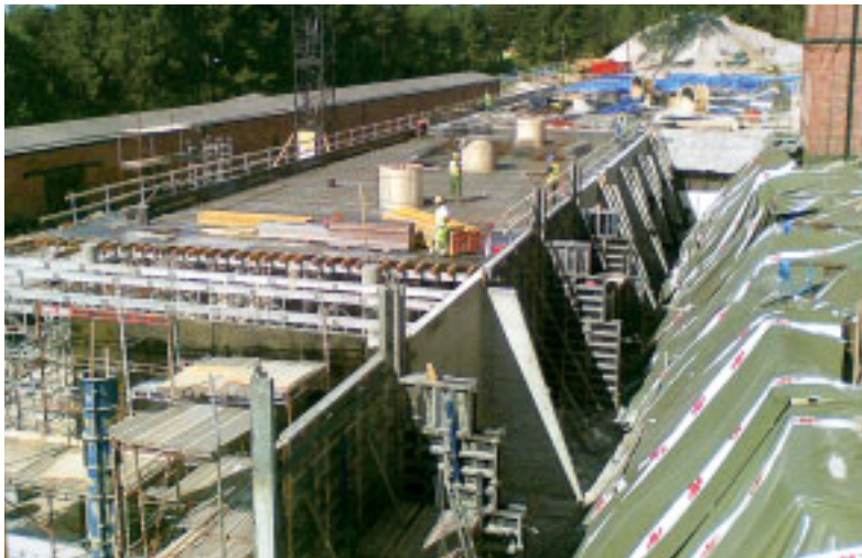
7 Näkymä työmaalta kirjaston alueelta kesällä 2009.
