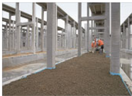
1 Lattian alustäyttö tehdään huollisesti. Sen on oltava riittävän kantava ja tasainen sora-/sepelipohja.
