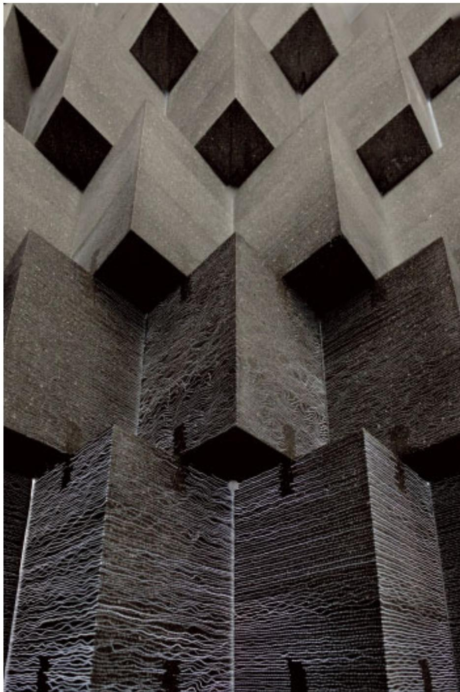
Valobetonissa käytetään korkealujuuusbetonia, jonka puristuslujuus voi olla jopa 150 MPa ja taivutuslujuus 12 MPa. Tämä mahdollistaa käytön myös ohuina laattoina hyvin monipuolisesti sekä sisä- että ulkotiloissa. Materiaali on vesitiiivistä sekä pakkasenkestäävä. 20 mm:n paksuisen laatan hinta on noin 600 - 850 euroa/m<sup>2</sup>.
