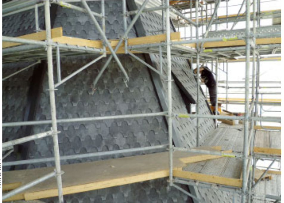
3 Paanojen asennus käynnissä kellotapulissa.
