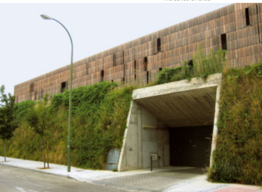
9, 10 Carabanchel lähiössä arkkitehtitoimisto FOA (Foreign Office Architects) on käyttänyt asuintalon julkisivumateriaalina bambuverhoilua.
