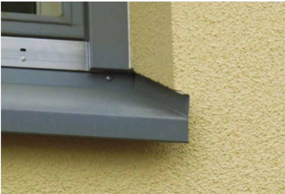
9 Esimerkki rappausreunalla toteutetusta ikkunan vesipelistä.
