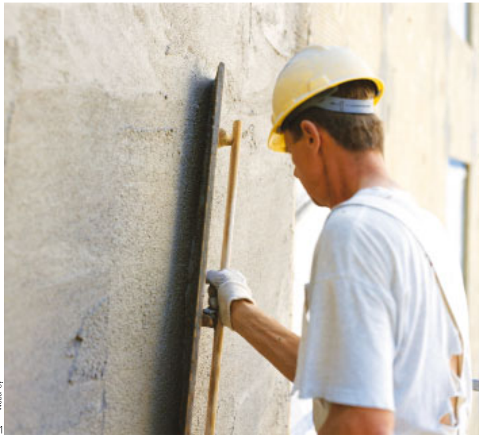
11 Paksurappaus-eristejärjestelmän täyttörappauksen pinnan työstö pintarappauksen alustaksi.
