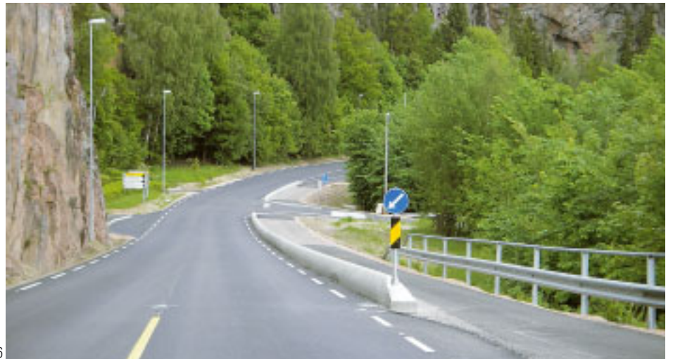
6, 7 Autotien ja kevyenliikenteen väylän välinen matala keskikaide. Matala keskikaide erottaa kevyenliikenteen väylän turvallisesti ajoradasta. Kuvassa 7 matalan kaiderakenteen poikkileikkausesimerkki.
