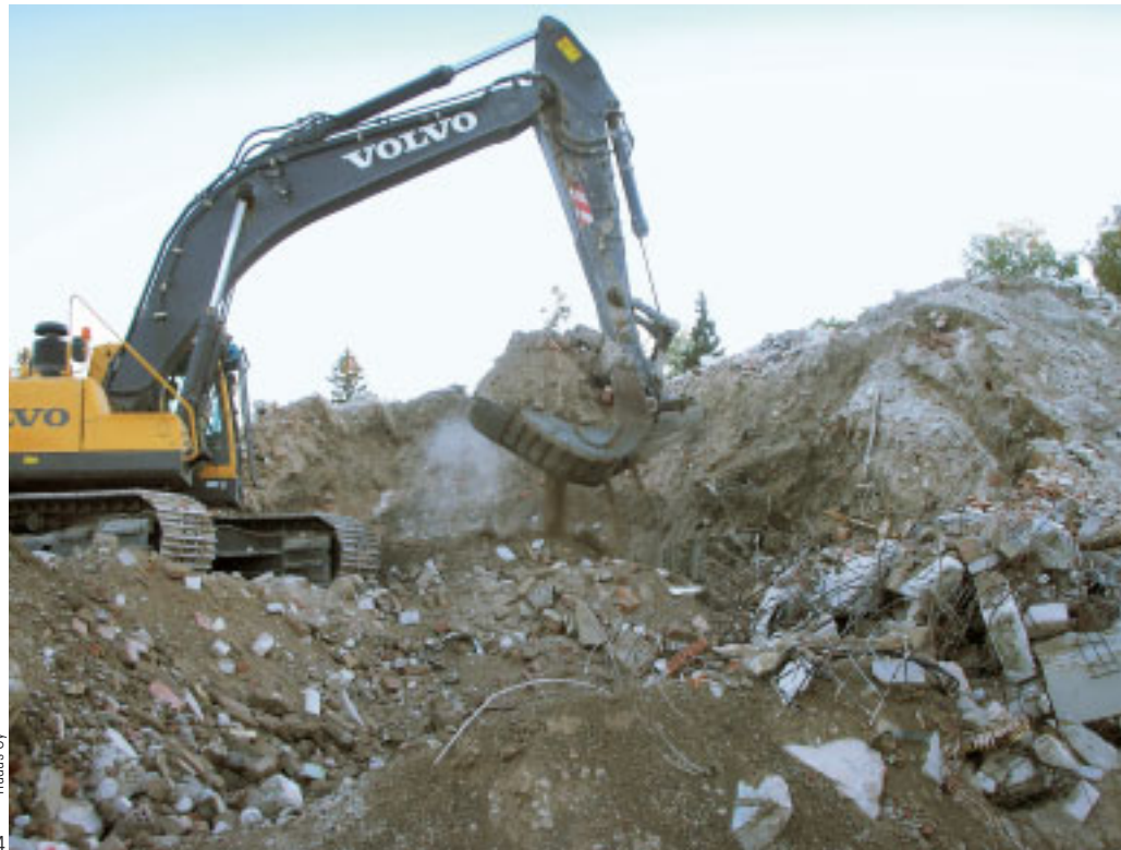
3 Betoniäätettä odottamassa jalostusta Betoroc-murskeeksi Helsingin Konalassa.
