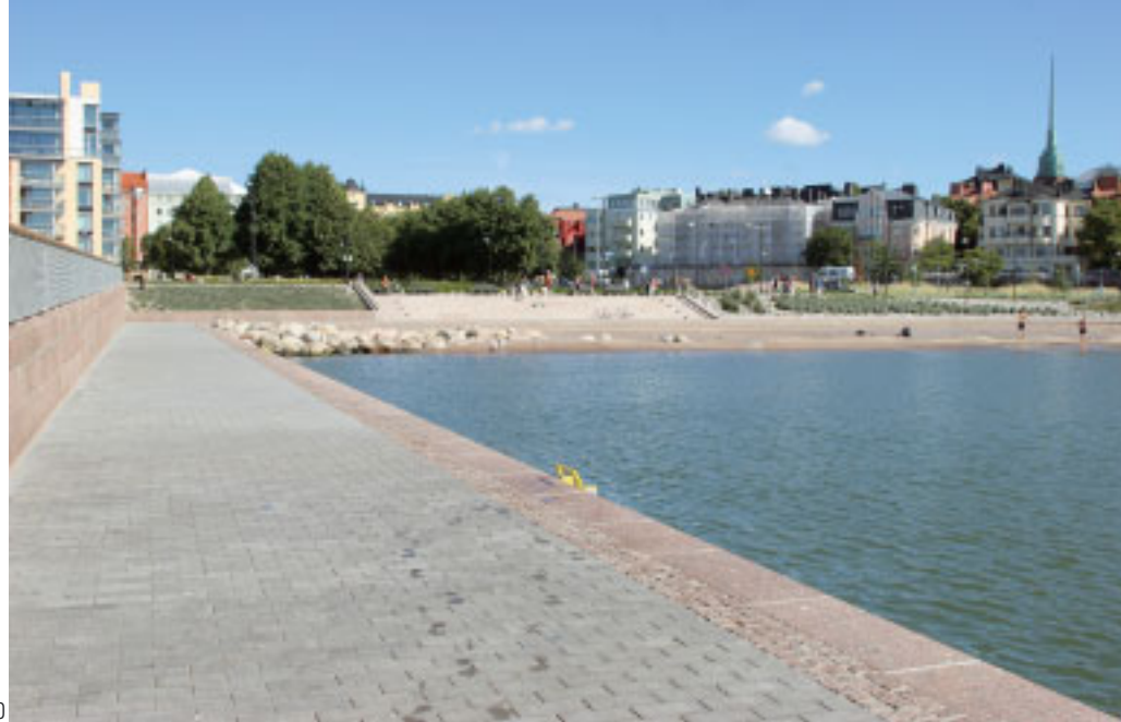
10 Betonielementtirakenteinen tukimuuri on verhoiltu luonnonkivellä.
