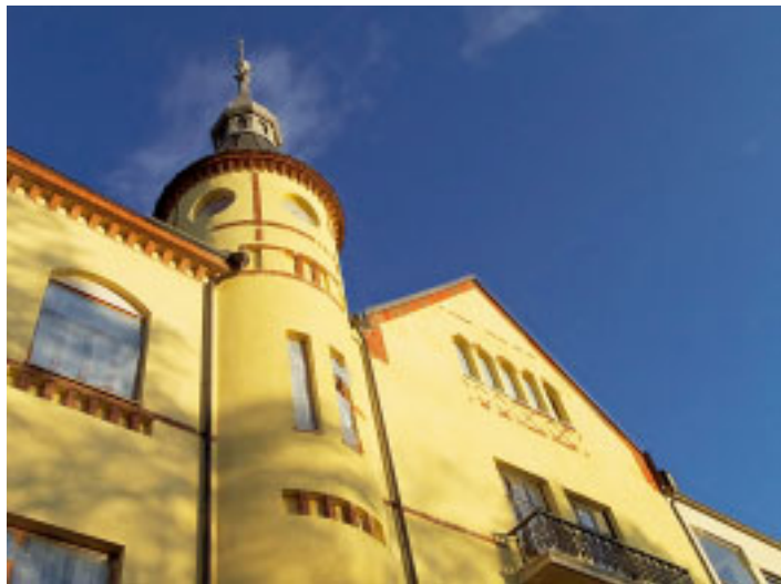
5 Hotelli Regattan julkisivut peruskorjattuna.
