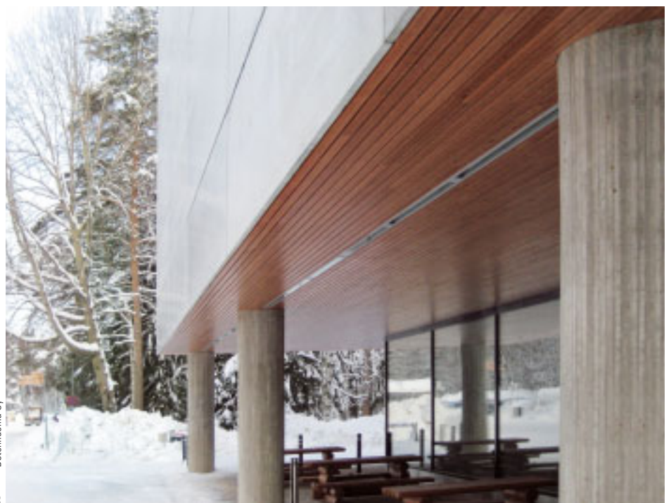
4, 5, 8 Uuden julkisivun käyttöikäarvio on yli sata vuotta; kiinnikkeet ovat haponkestävää terästä, elementtien rauditus on ruostumatonta terästä ja betoni korkealaatuista.
