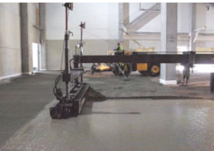
9 Laserohjattu tärypalkki, Somero laserscreed SXP.
