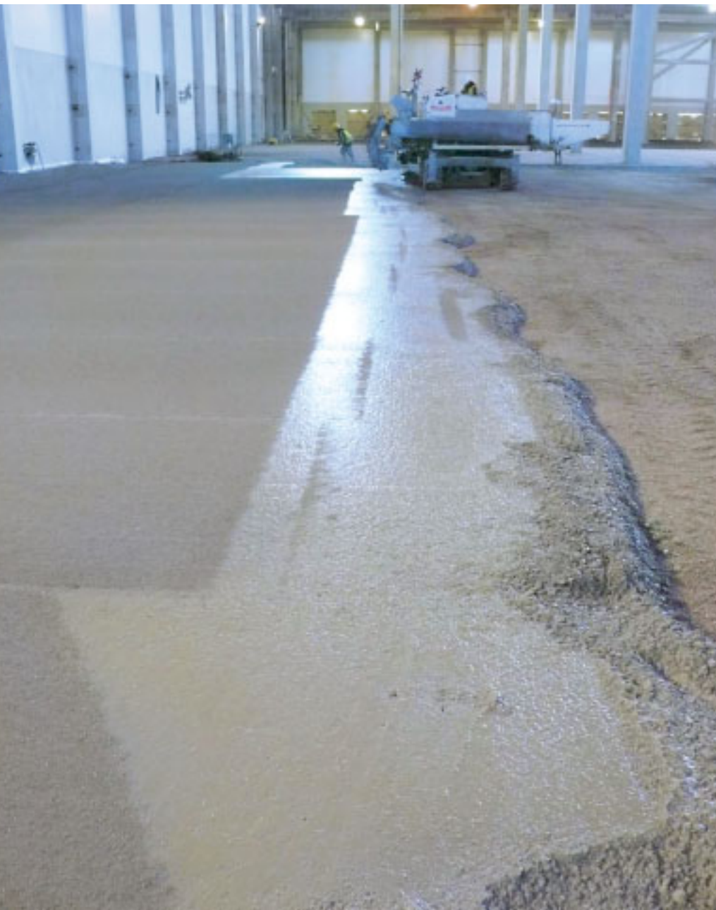
8 Lattian betonointityö tehtiin valukaistoittain noin 4-6 metriä leveinä kaistoina.
