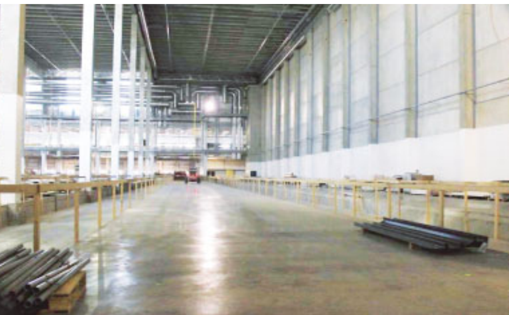
16 Valmis lattia. Hyllyjen runkojen asennus on aloitettu.
