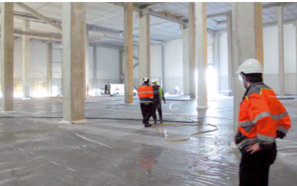
15 Hierron jälkeen pinta kastellaan ja levitetään jälkihoito- peitteet halkeilun minimoimiseksi.
