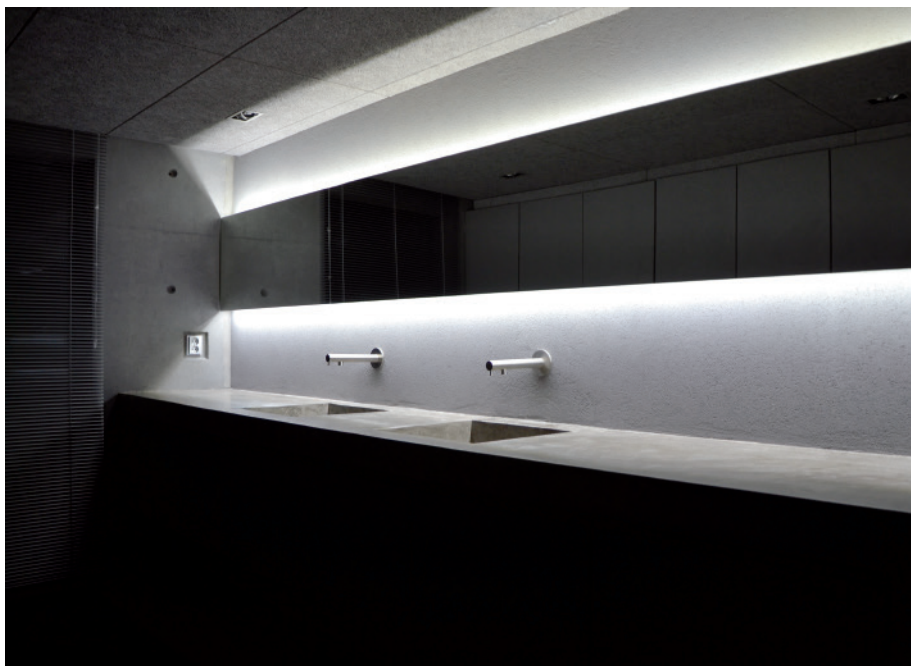
18, 19 Wc-tilojen betonitasot sekä keittiön saarekkeet ja ruokapöytä valettiin paikan päällä. Suojapinnoitteen tasoihin, kosteiden tilojen lattioihin ja suihkuseiniin teki Lattiamies.
