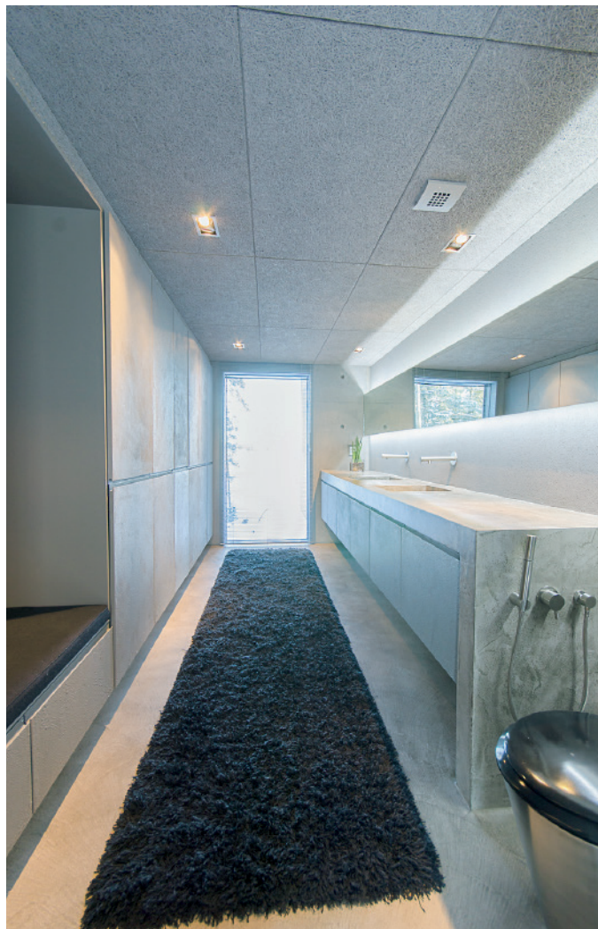
18, 19 Wc-tilojen betonitasot sekä keittiön saarekkeet ja ruokapöytä valettiin paikan päällä. Suojapinnoitteen tasoihin, kosteiden tilojen lattioihin ja suihkuseiniin teki Lattiamies.
