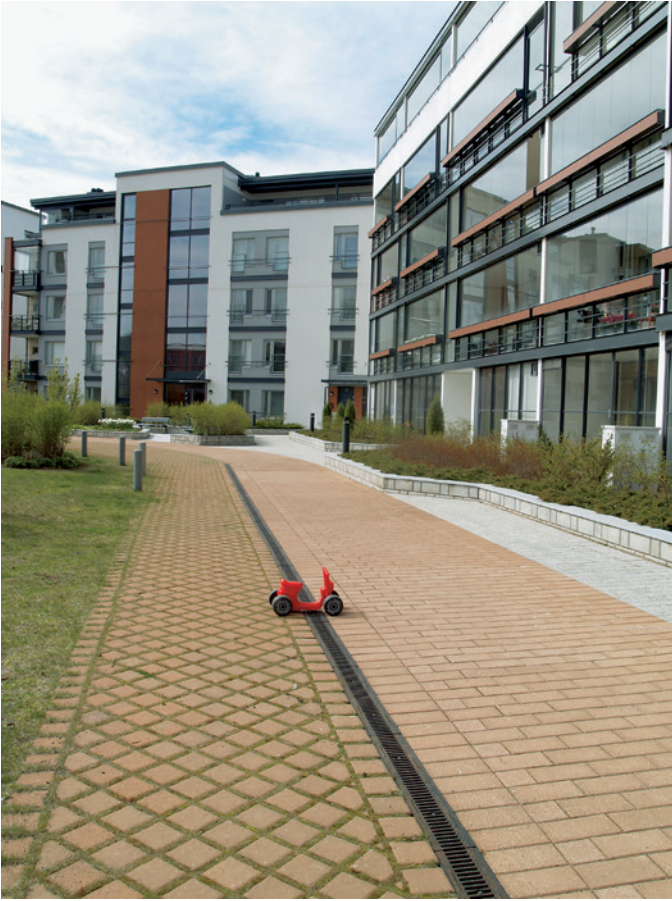
10 Lauttasaassa pari vuotta sitten valmistuneen Heikkiläntien asuntokorttelin yhteispiha on kivetty erilaisilla betonikivillä. Golf-kivi rajaa nurmialueen ja toimii samalla vettä läpäisevänä päällysteenä.
