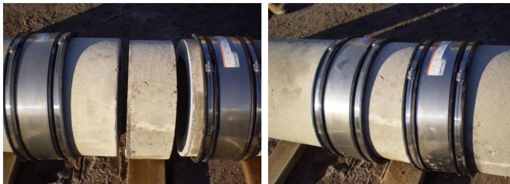
Flexseal-liitosmuhvien ja betoniputkesta oikean pituiseksi sahatus sovittepalan avulla putkiliinjaston pultuuden säätäminen on työmaalla helppoa ja nopeaa.
