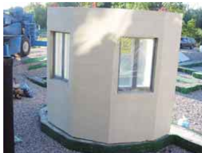
UH Rakennus Oy 4
