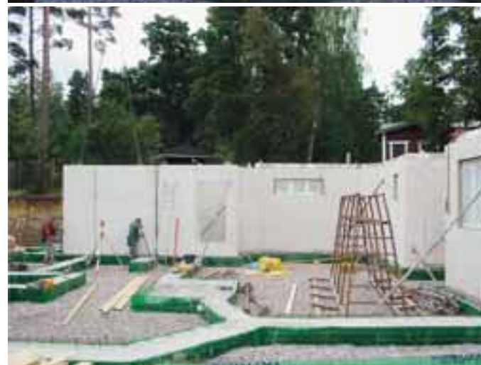
UH Rakennus Oy 5
