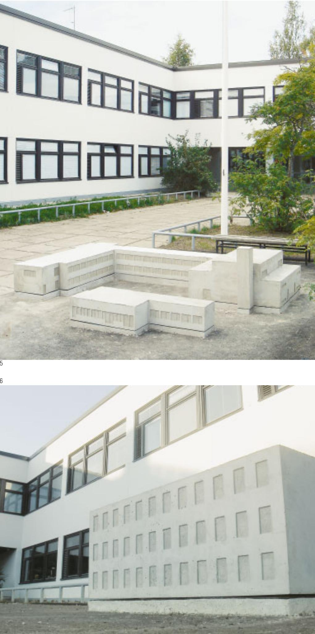
Minikoulu rakennettiin kesällä 2007. Puusepät Kaj Lindholm ja Timo Kortelainen rakensivat muotit filmivanerista, kärsivällisesti reilut 500 ikkunaan ja ovea leikaten ja kiinnittäen vanerin sisäpintaan.
