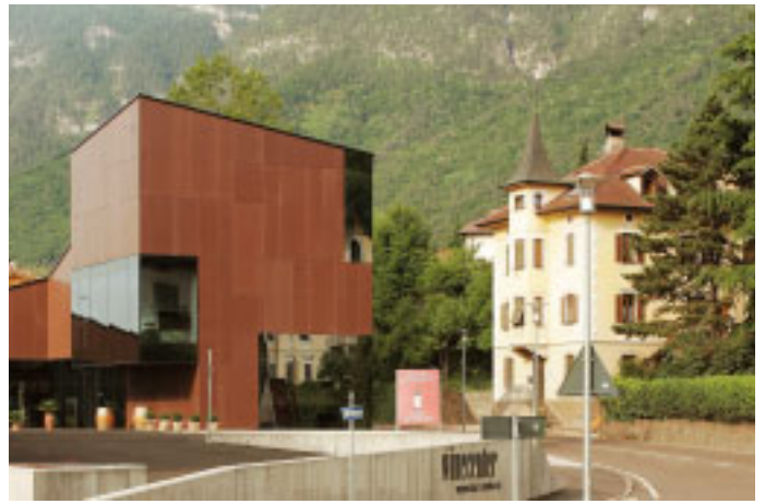
6 Winecenter Kaltern, Itävalta, feld72 Architects
