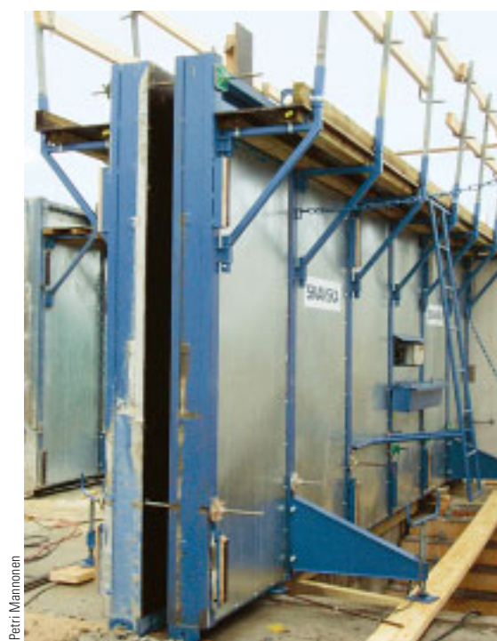
3 Suurmuotti, jossa on muottipinnan takana sähkövastukset. Betonivalua lämmitetään sähköllä.
