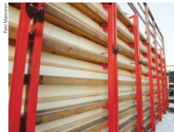
2 Lämpöeristetty seinämuotti, johon asennetut lämmöneristyslevyt estävät betonissa olevaa lämpöä poistumasta rakenteesta.
