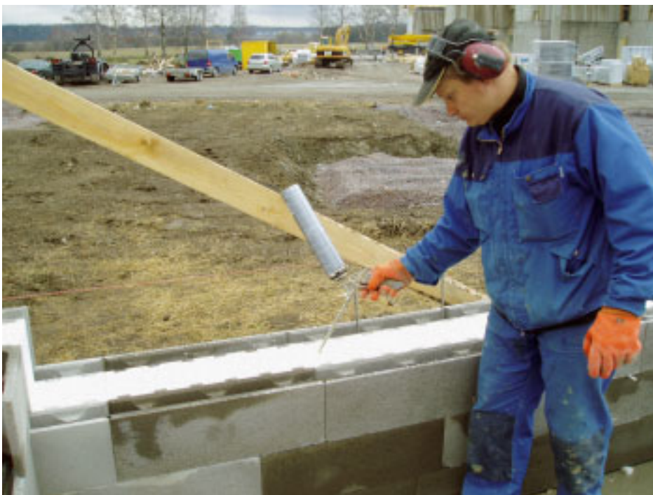
Lammim Betoni Oy 6
