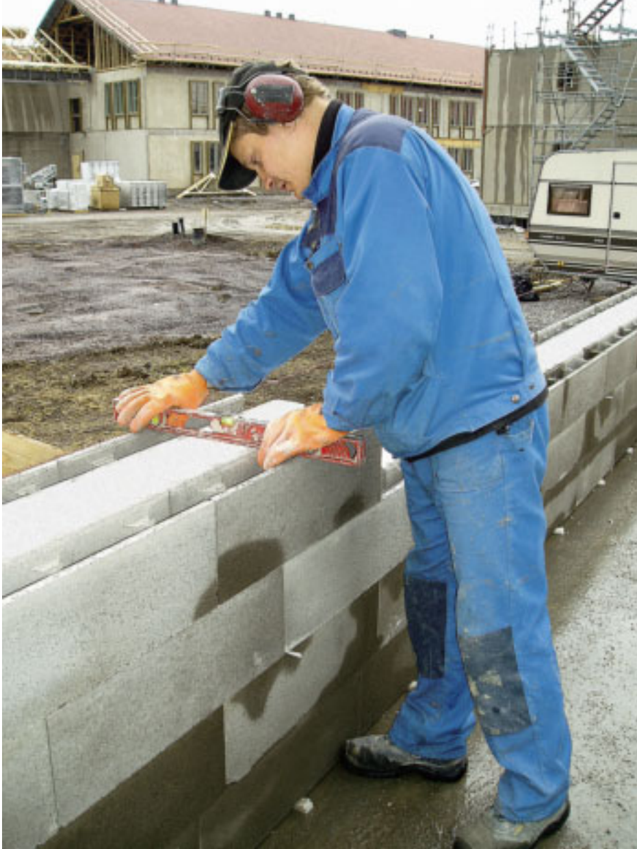
Lammim Betoni Oy 5
