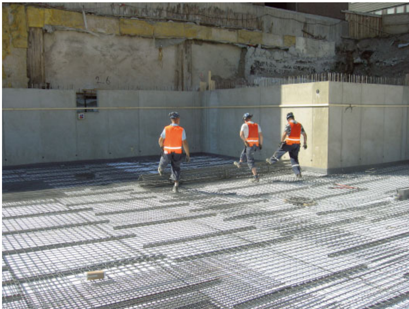
9 Bamtec matoraudoitteiden asennus kerrostalokorttelin alapohjassa.
