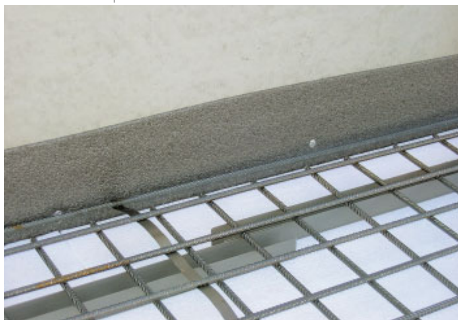
6 Laatan ja kantavan pystyrakenteen välinen solumuovinen eristekaista.
