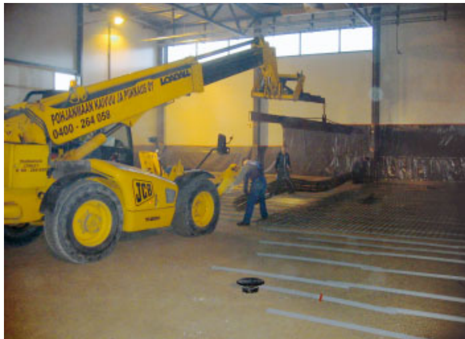
8 Bamtec matoraudoiteiden asennus teollisuushallissa.
