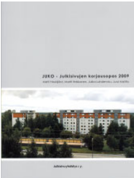
11 As. Oy Eteläkärjen pihajulkisivun vanhat betonisandwich-elementit lisäkiinnitettiin ja julkisivupinnat verhottiin uudella eristerappauksella. Tuuletusparvekkeiden rakenteet korjattiin betonikorjausmenetelmiä käyttäen. Pihan puolen julkisivun kaikkien asuntojen ikkunat uusittiin.
