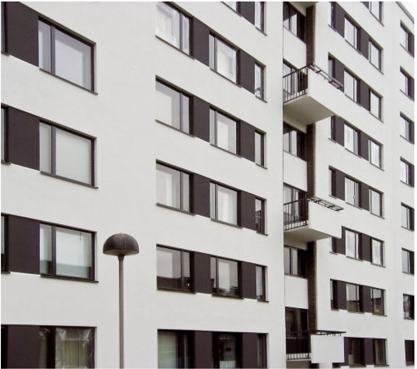
11 As. Oy Eteläkärjen pihajulkisivun vanhat betonisandwich-elementit lisäkiinnitettiin ja julkisivupinnat verhottiin uudella eristerappauksella. Tuuletusparvekkeiden rakenteet korjattiin betonikorjausmenetelmiä käyttäen. Pihan puolen julkisivun kaikkien asuntojen ikkunat uusittiin.
