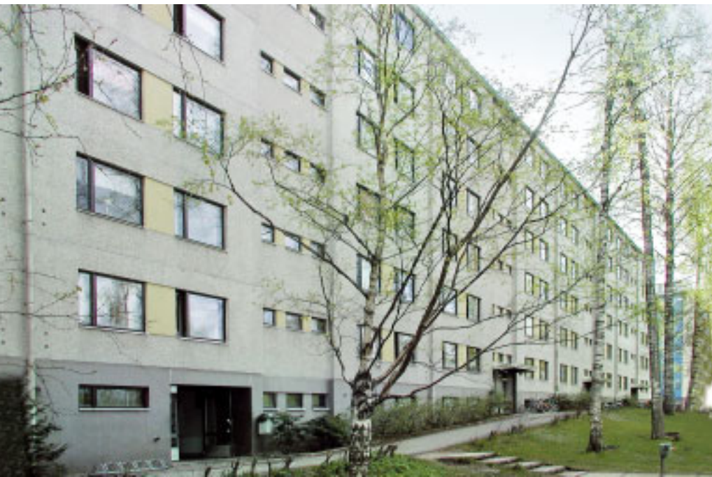
1 Asunto Oy Myyränkolon katujulkisivu ennen korjausta.
