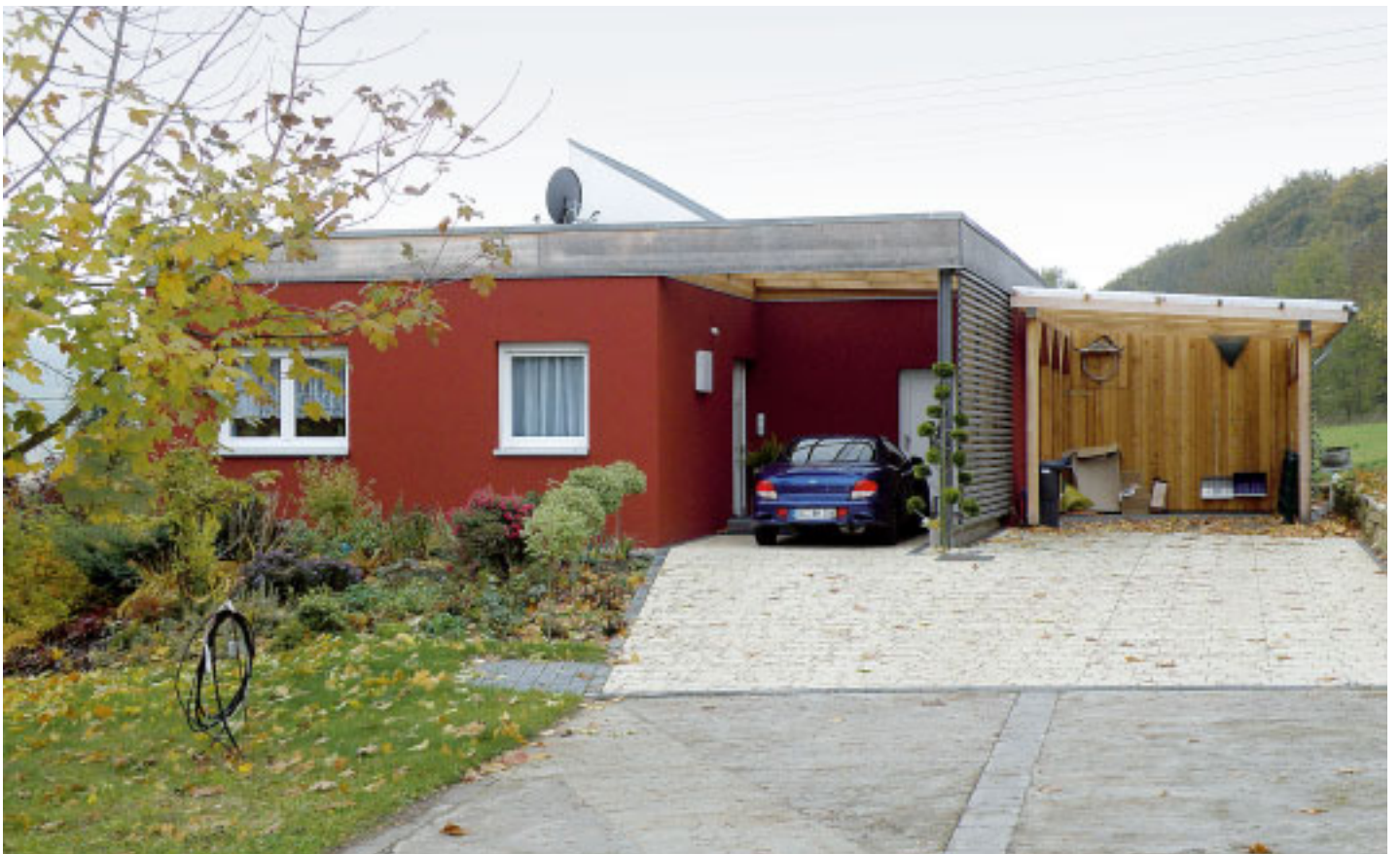
6 Purkuelementeistä rakennettu moderni omakotitalo Ber- liinissä. Alakerran seinät on tehty välipohjajelementeistä suuremman huonekorkeuden saavuttamiseksi. Arkkitehti- toimisto Conclus.
