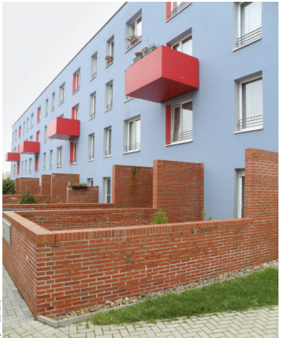
5 Piiloripustettu punainen noppaparveke, sininen julkisivu- väri ja tiillimuurit toistuvat erilaisina variaatioina Leine- felden saneerauksissa. Arkkitehtitoimisto Stefan Forster.
