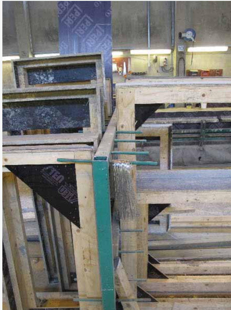
Betonimestarit Oy, Haapavesi Lasse Heikkilä
