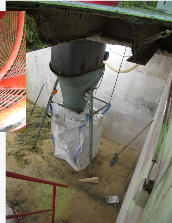
Lujabetoni Oy, Siilinjärven seinätehdas Harri Niemi
