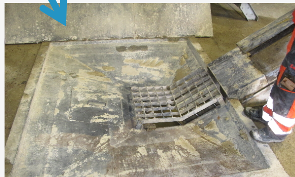
Ylijäämäbetoniallas
