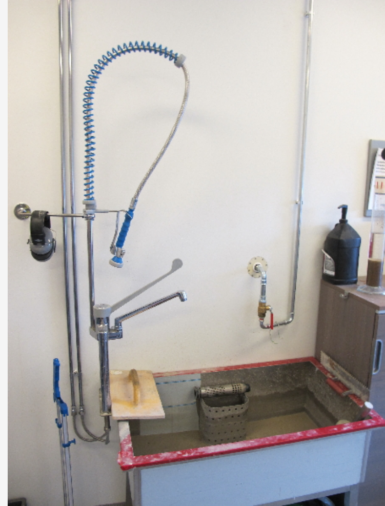
Lujabetoni Oy, Nokian valmisbetonitehdas Anssi Tiukka
