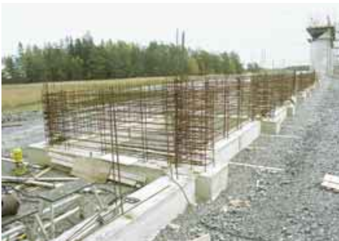
6, 7, 8 Muuri on perustettu 400 mm korkealle anturalle. Muurin seinärakenne jäykistetään jännittämällä seinämät pituus-suunnassa.
