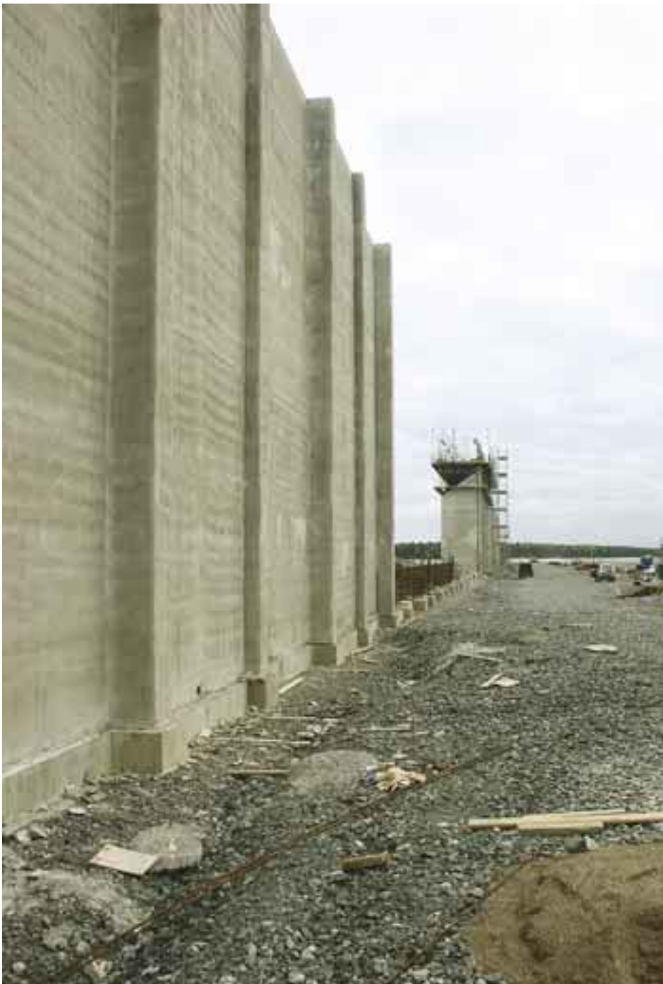
9, 10 Muurin seinämän paksuus on 250 mm. Liukuvalettavan seinän valun nousunopeus on 200 mm tunnissa.
