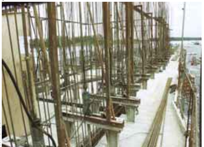
6, 7, 8 Muuri on perustettu 400 mm korkealle anturalle. Muurin seinärakenne jäykistetään jännittämällä seinämät pituus-suunnassa.
