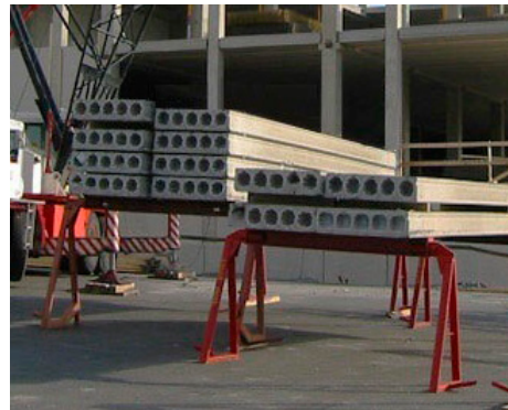
Ontelolaatat voidaan varastoida myös erillisten valmiskuormapukkien päälle.
