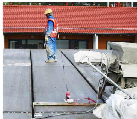
Ontelolaatta-asennuksessa suositellaan käytet-tävän henkilökohtaista putoamissuojausta.
