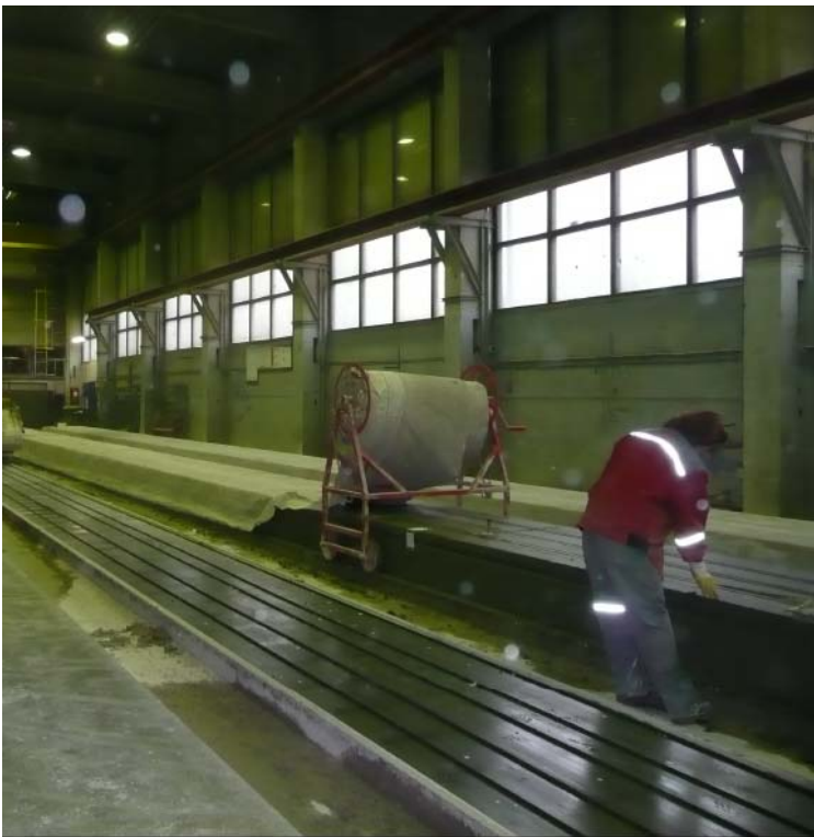
Kuva 8. Ontelon suojapeitteen levityksessä käytetään apuna rullatelinettä
