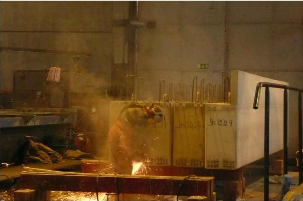
Kuva 6. Jännepunoksen viimeistelykatkaisu kulmahiomakoneella
