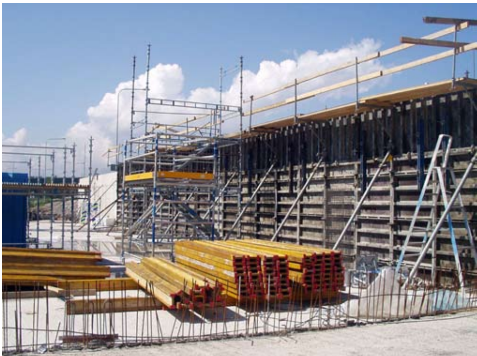
Kuva 10. Erillinen teline kulkutienä työtasolle. Työtason kaiteessa jalkalistojen asennus kesken.
