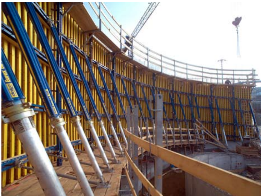
Kuva 4. Siistillä ja järjestyksessä olevalla työmaalla työskentely on turvallisempaa ja tuottavampaa.
