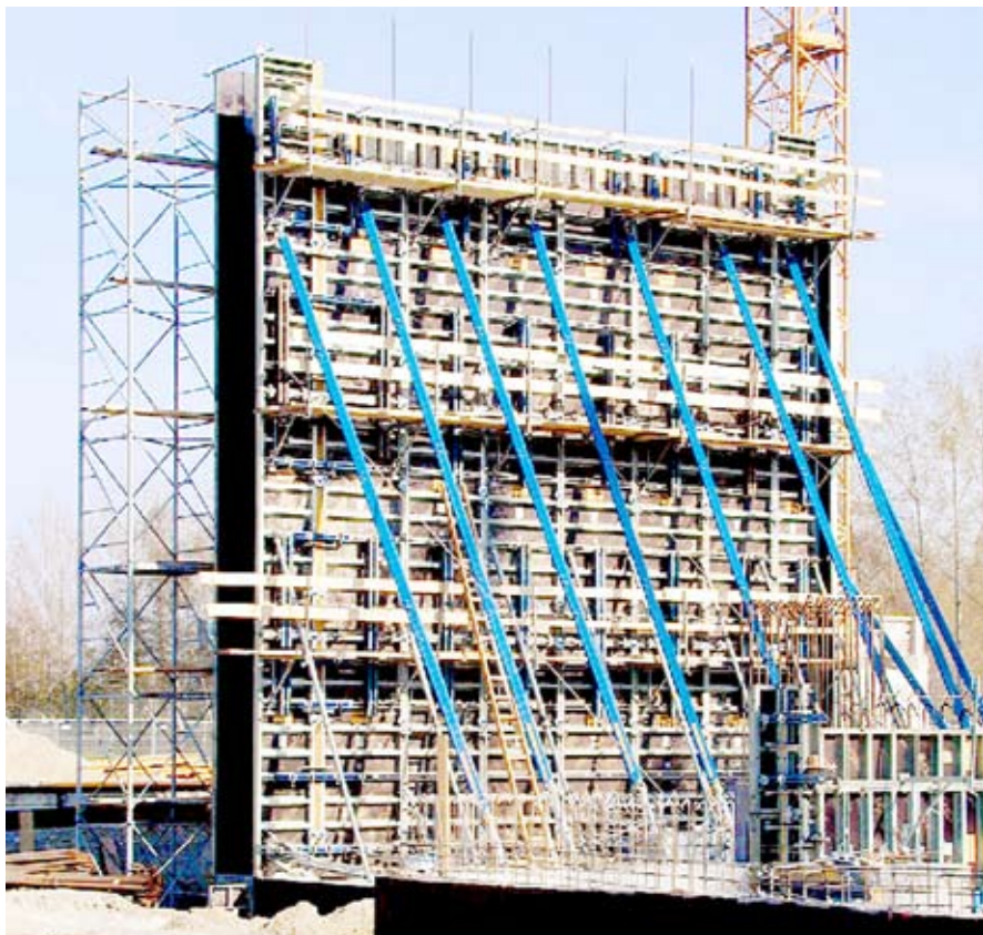
Kuva 12. Työtasot kiinnitetään muottiin ennen muotin asennusta.
