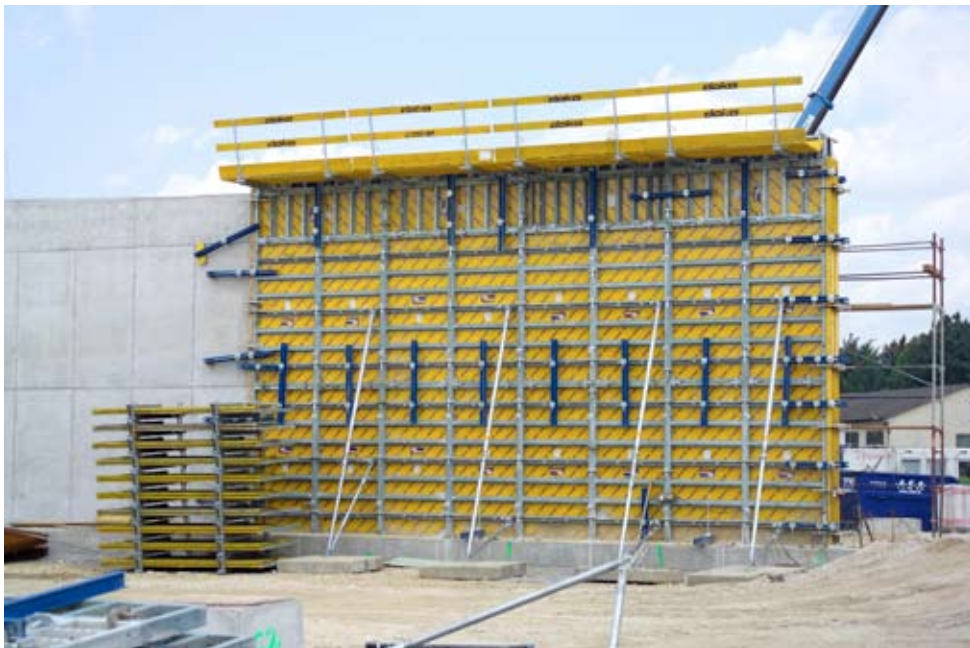
Kuva 8. Muottiin kiinnitetty työtaso ja kaide.
