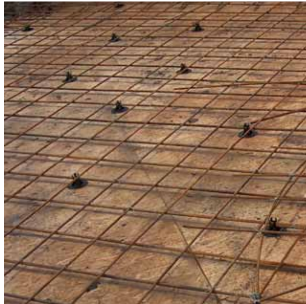
Kuva 10 Raudoituskorokkeet pitävät raudoitusverkon suojaetäisyyden päässä muotista.
