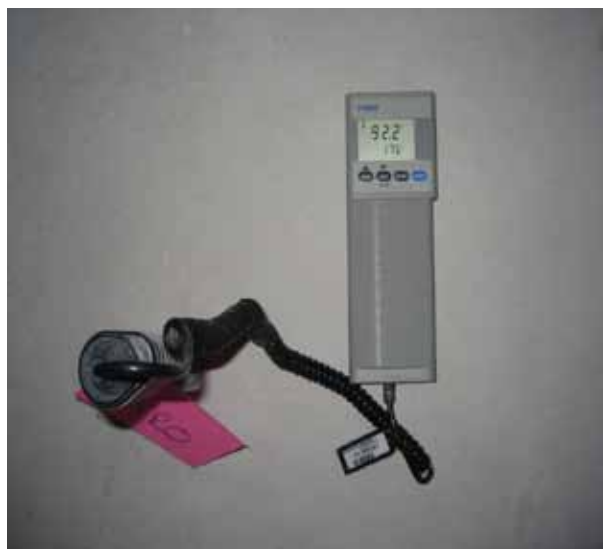
Kuva 15 Betonin suhteellisen kosteuden mittaaminen lattiaan poratusta reiästä.
