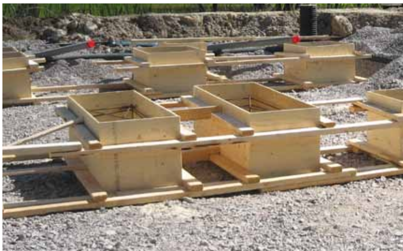
Kuva 3 Paaluanturoiden muotit.
