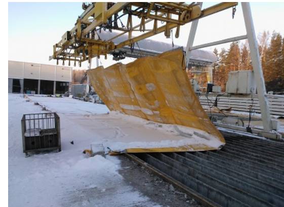
Lämpöpeitettä oltiin vetämässä pois muotin päältä.
