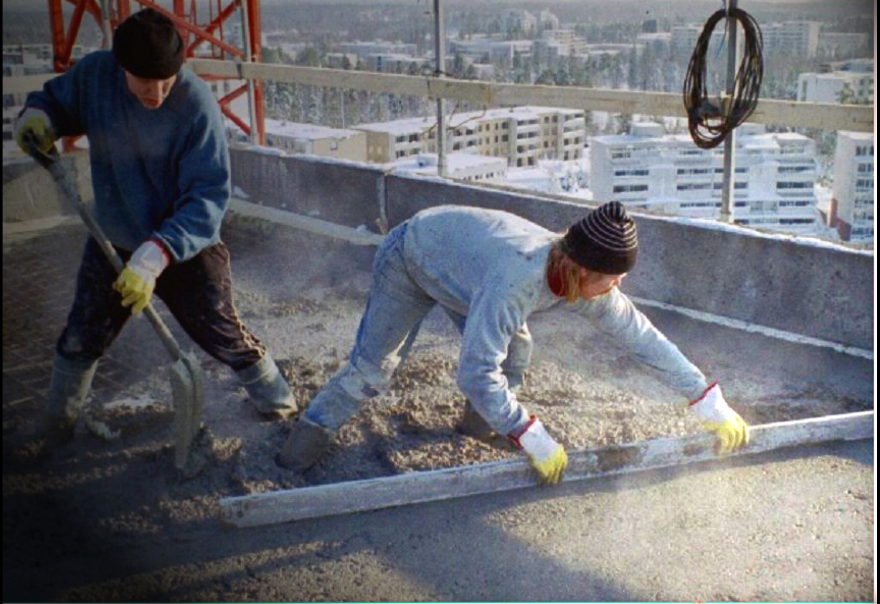
Betoni työssä Kauko Linna
