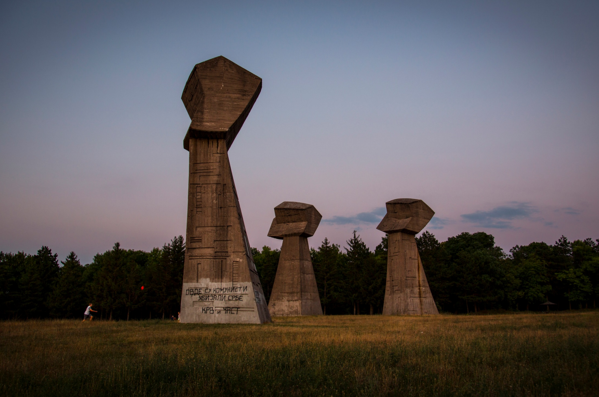
Betoni taiteena / Aino Väänänen
