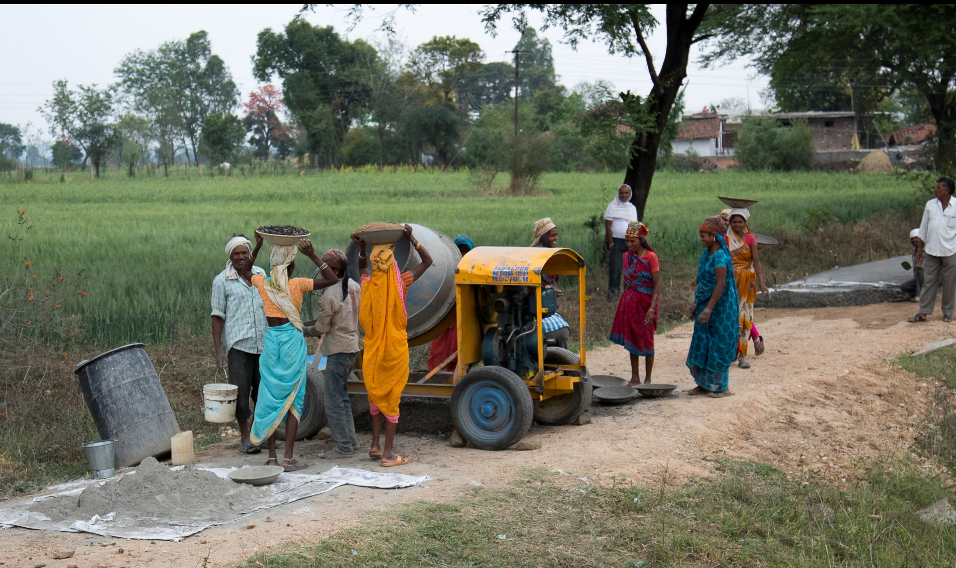
Betoni työssä / Olli Korander
