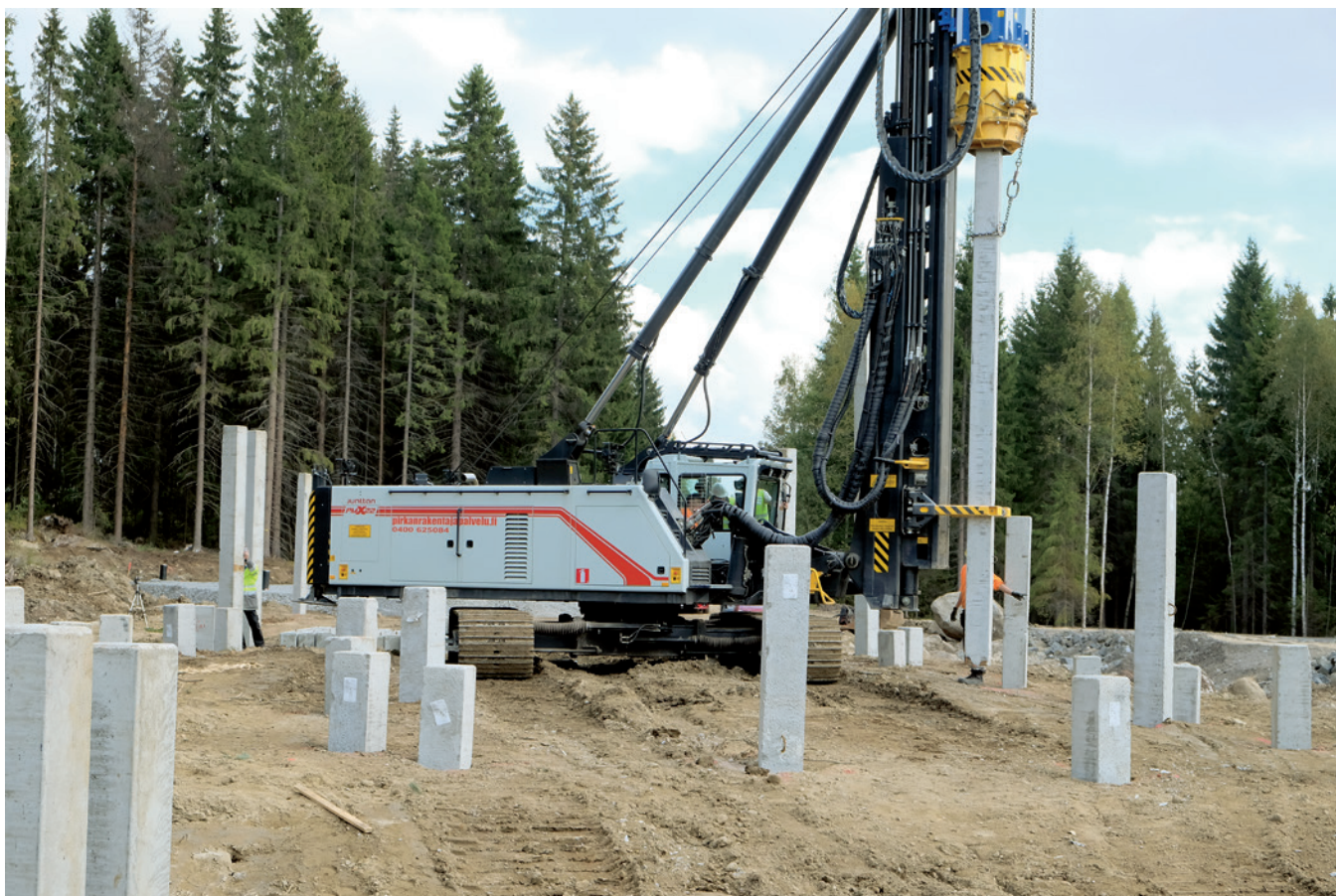
1 Teräsbetonipaalujen lyöntipaalutus meneillään.
