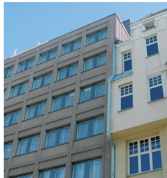
14 Lapinlahdenkatu 1:n toimistotalon peruskorjaus
