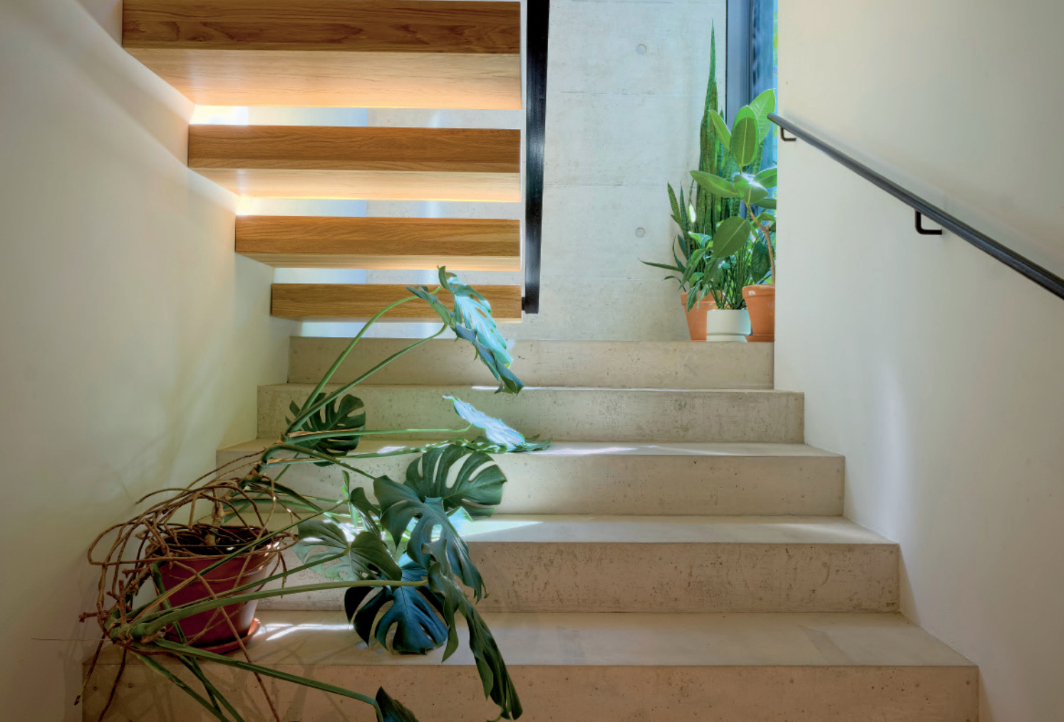
17 Sisäporras on paikallavalettu.
