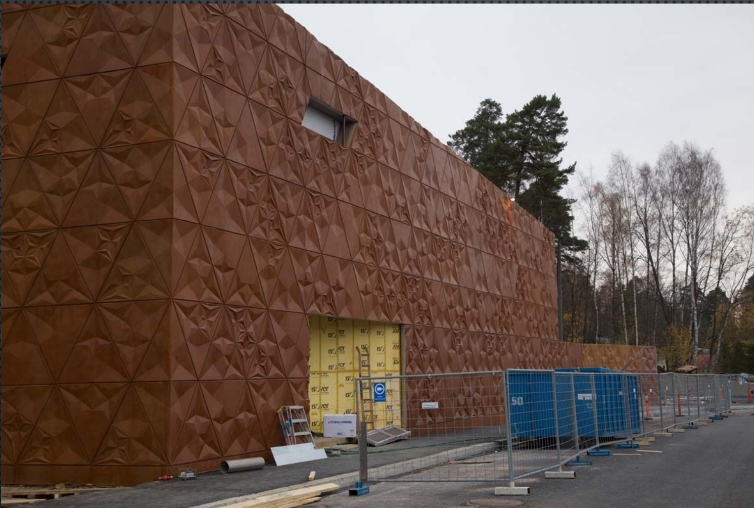
KRUUNUVUORENRANNAN KOTA-ASEMA: Nikolai Rautio ja Timo Kiukkola, Arkkitehtuuritoimisto B & M Oy
