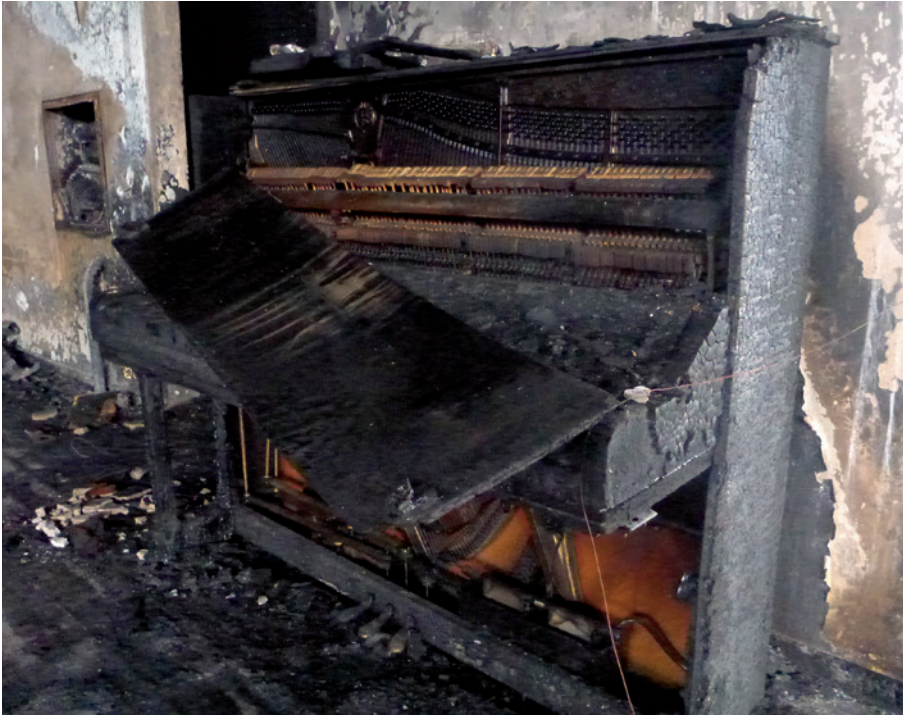
3, 4 Havainnot muista rakennusmateriaaleista auttavat palossa vaurioituneiden lämpötilojen ja sitä kautta betonin vaurioitumisriskin arvioinnissa.
