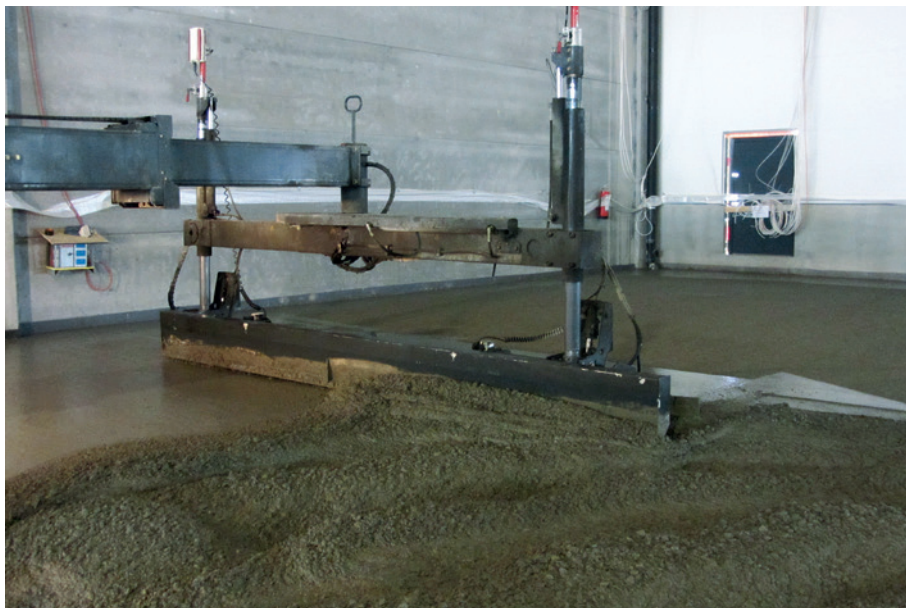
6, 7 Betonimassan levitys laserohjatulla levityskoneella ja reunojen viimeistely oikaisulaudalla.
