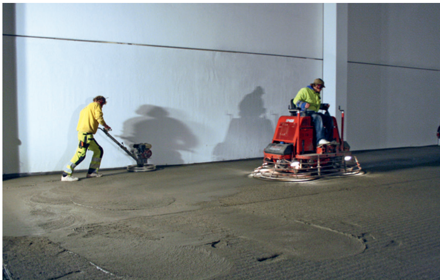
9 Betonilattian reuna- ja keskialueen hierto.
