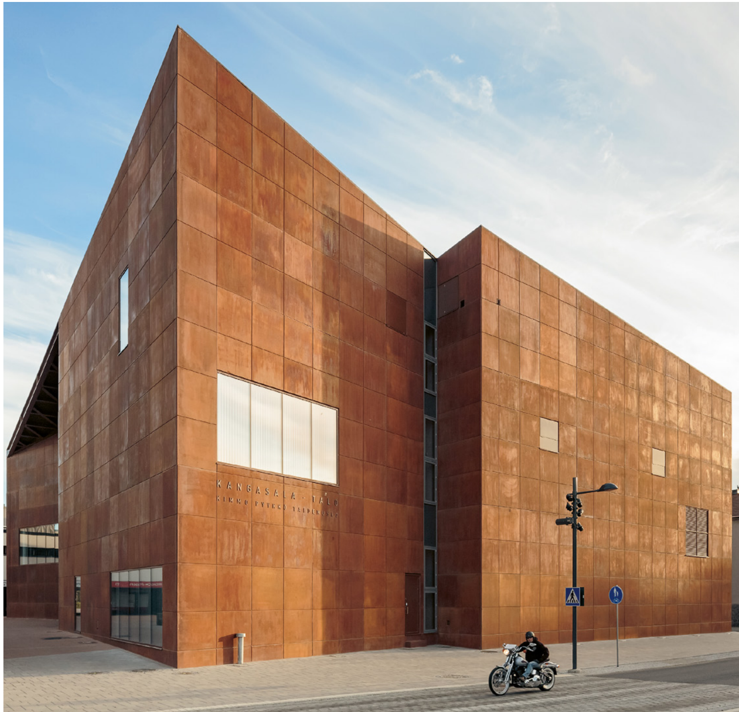
Kangasala-talo, Kangasala. Arkkitehtuuritoimisto Heikkinen-Komonen Oy. Vuoden Betonirakenne 2015.
