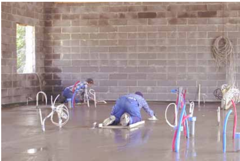
Kuva 13 Pintalaatan hiertoa käsin.
