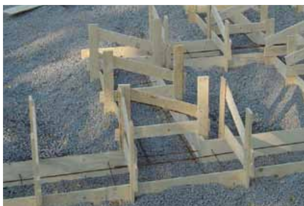
Kuva 7 Matala anturamuotti sahatavarasta.
