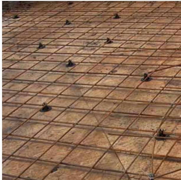
Kuva 10 Raudoituskorokkeet pitävät raudoitusverkon suojaetäisyyden päässä muotista.
