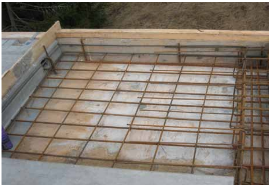
Kuva 9 Ontelolaattavä-lipohjan paikallavaletta- van osan raudoitusta ja muotti.
