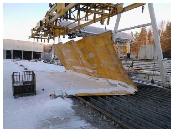
Lämpöpeitettä oltiin vetämässä pois muotin päältä.
