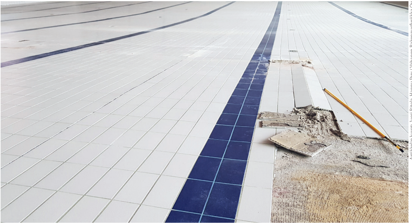
Artikkelin kuvat: Jussi Ritola, Hannu Pyy / Vahanen Rakennusfysikka Oy
